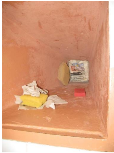
3. sz. kép: a mellékhelyiségbe néző kémlelőnyílás
