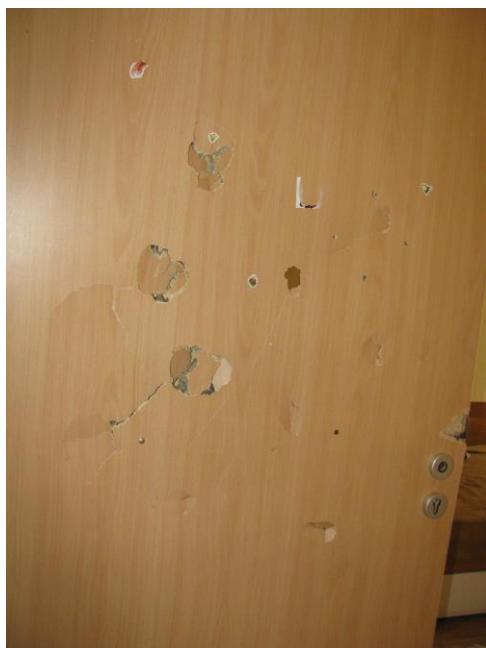
7. sz. kép: Beszakított ajtó a csoporthelyiségekben
