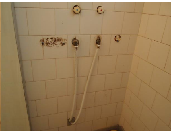
10. kép: Zuhanycsap cső és rózsa nélkül
