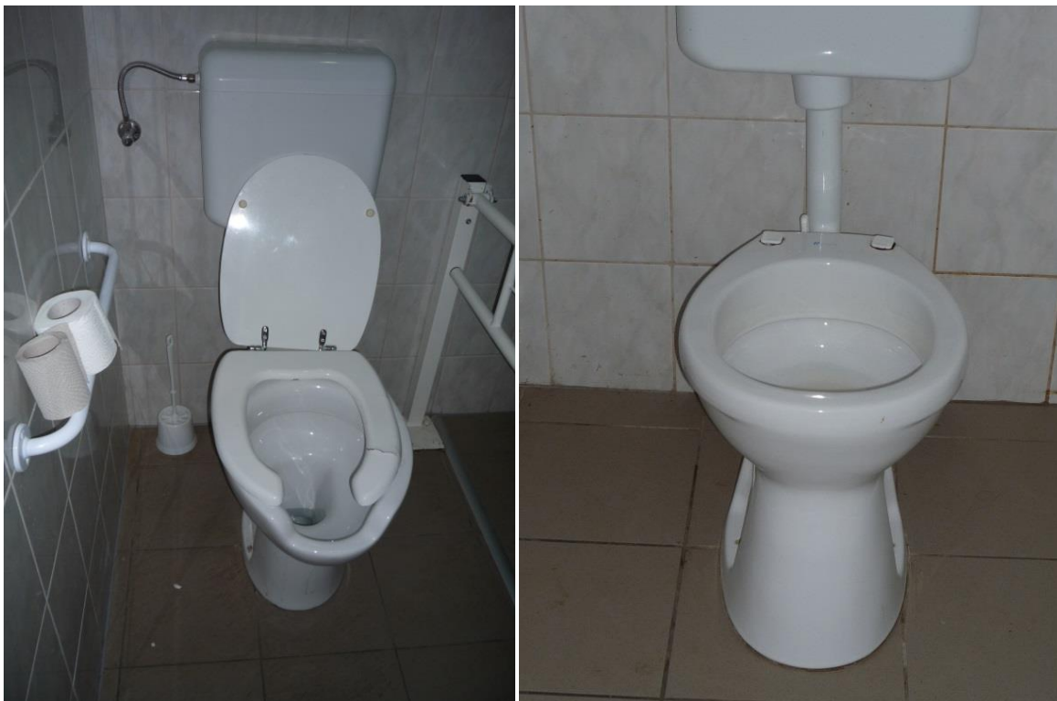
4. sz. kép: IV-es ápolási egység – Az egyik WC deszka törött volt, a másiktól hiányzott a deszka.
