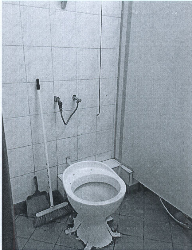
4. kép: hiányzó WC-ülőke és fedél
