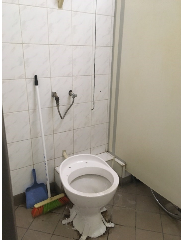
4. kép: hiányzó WC-ülőke és fedél
