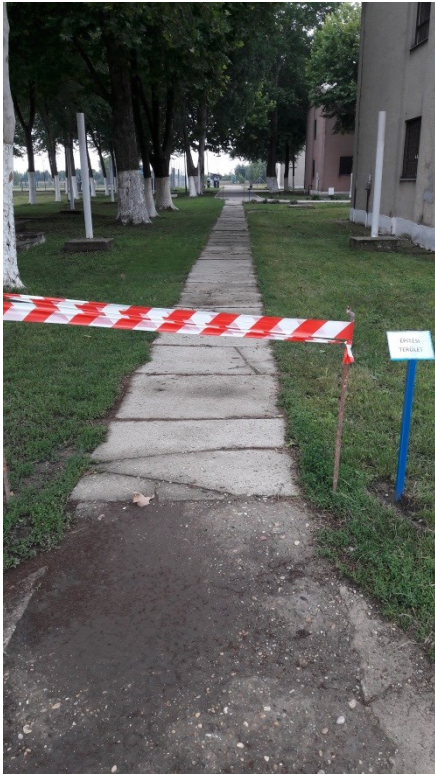
3. kép: töredezett járólapú betonút
